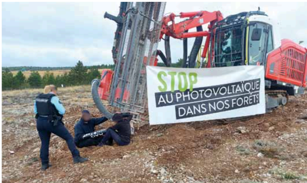
▲ Blocage d'une foreuse le 18 octobre 2023
